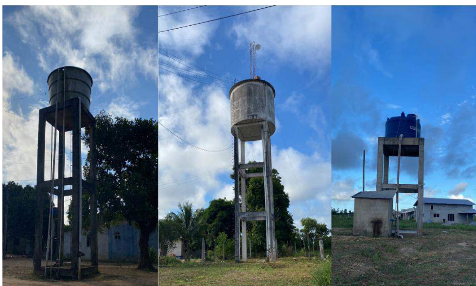
Figura 6-12: Reservatórios de água, Aldeia Pau Brasil.
