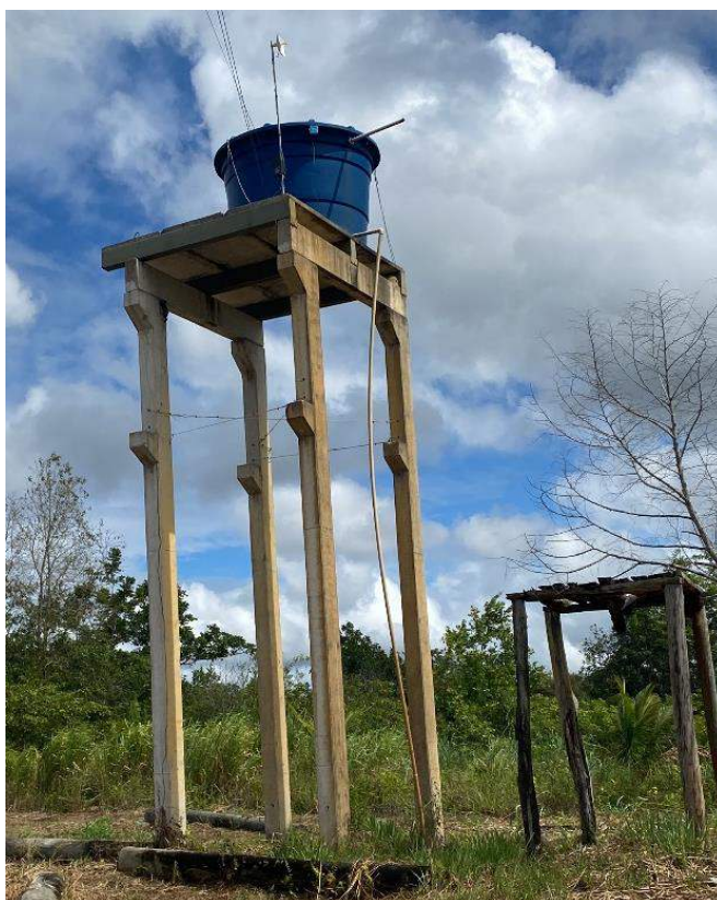
Figura 6-13: Reservatório, Aldeia Amarelos.
