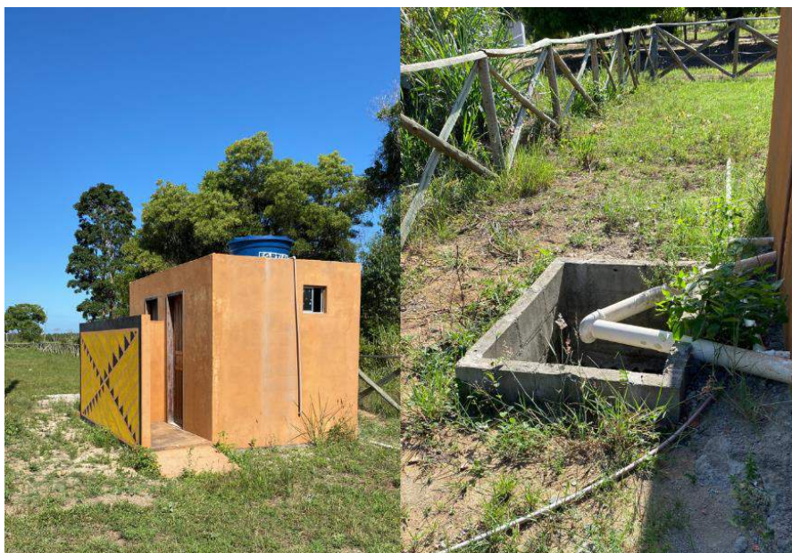
Figura 7-6: Banheiro com fossa, Aldeia Olho D'água.
