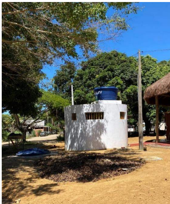
Figura 7-4: Banheiro com fossa, Aldeia Irajá.
