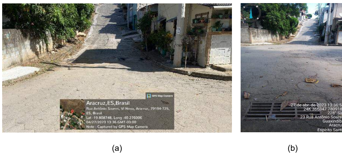
Figura 9-65: Vistas da Rua Antônio Soares.
