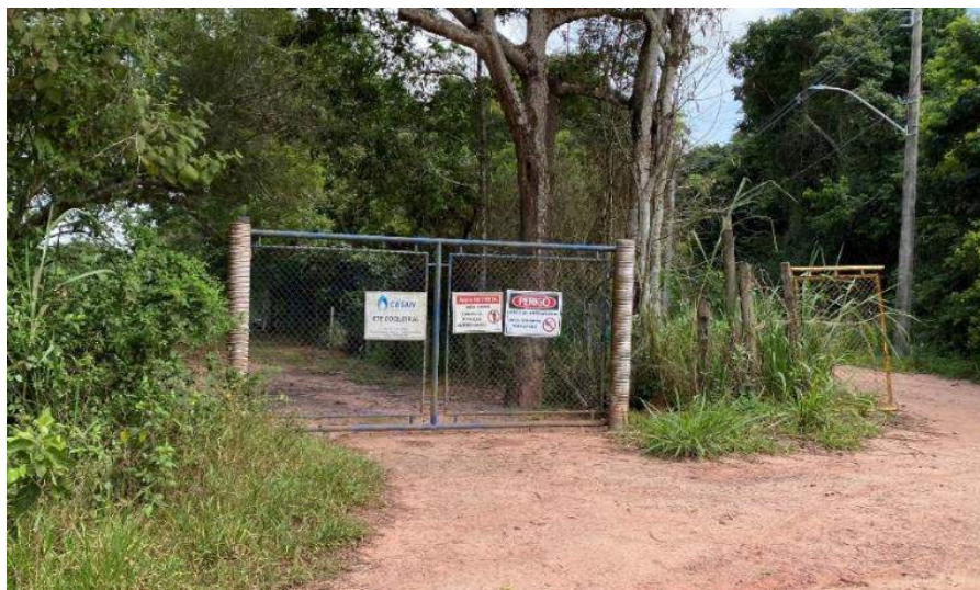
Figura 7-2: Entrada da ETE Coqueiral, Aldeia Piraquê-Açu.
