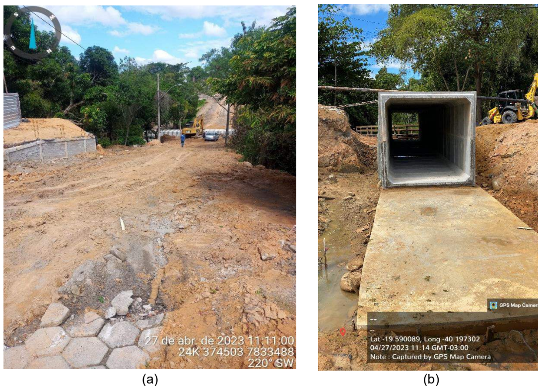
Figura 9-33: Reconstrução do bueiro no Córrego São José.
